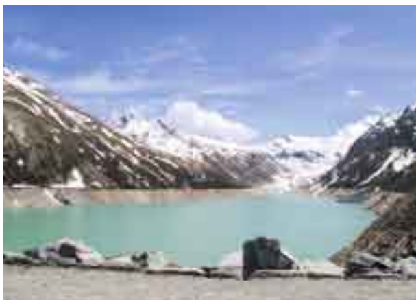
Staudamm zur Gewinnung von Wasserkraft
